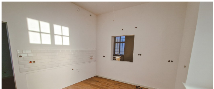
Pomieszczenie na parterze budynku dworu, znane dawniej jako „Butik u Krysi”, już przygotowane pod montaż kuchni
