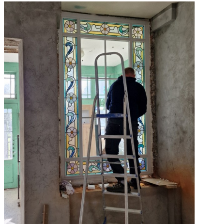
Montaż odnowionych witraży na parterze budynku dworu
