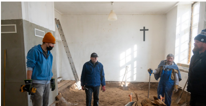
Prace w dawnej „kaplicy zimowej”, która w przyszłości będzie salonem kominkowym, 22 lutego 2025
