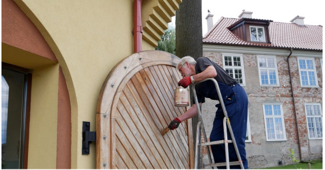
Sierpień to dobry czas na wykonanie szeregu prac konserwatorskich. Brat Zdzisław odświeżał dębowe wrota kaplicy.
