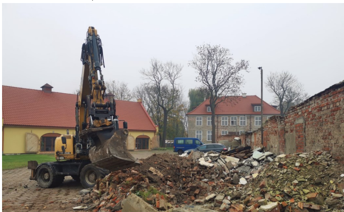
Z placu przed kaplicą wyjechały cztery wielkie ciężarówki gruzu, 31 października 2022
