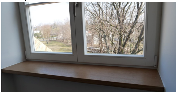
Nowe, dębowe parapety w oknach na poddaszu
