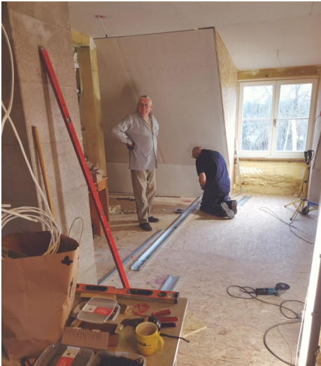
Na poddaszu powstają ściany przyszłych pokoi gościnnych
