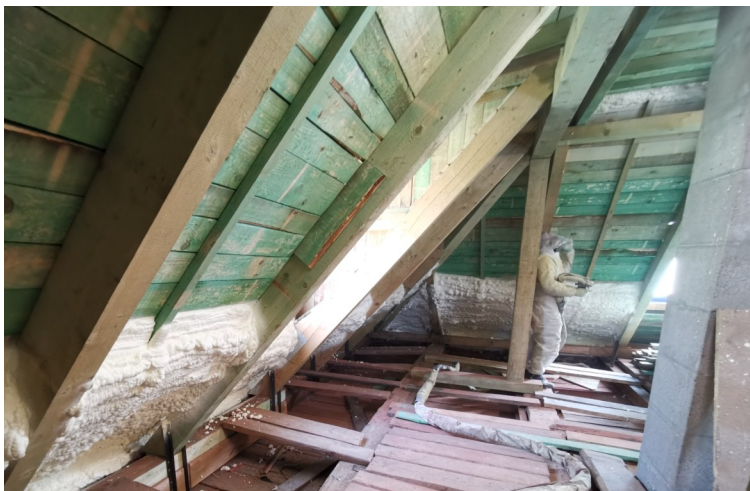
Beniamin całą sobotę pracował w ciężkich warunkach przy ociepleniu dachu budynku dworu. Byśmy byli gotowi na zimę.
