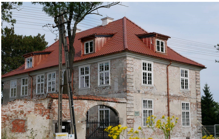
Nowy dach w pełnej okazałości
