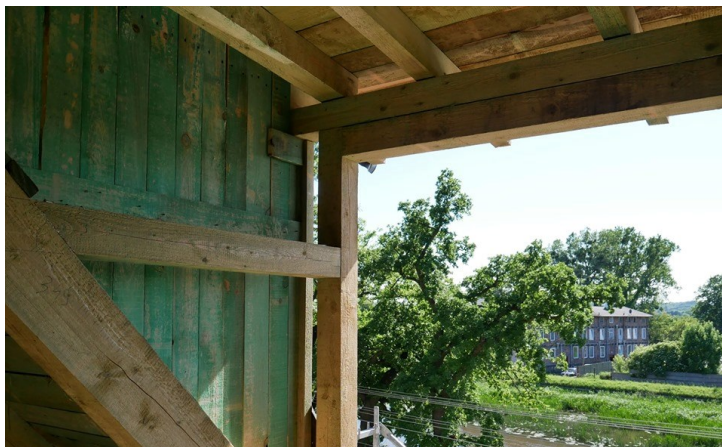
Oczekując na dekarzy zajęliśmy się deskowaniem ścian lukarn. Prace prowadził wspierający nas w budowie Krzysztof
