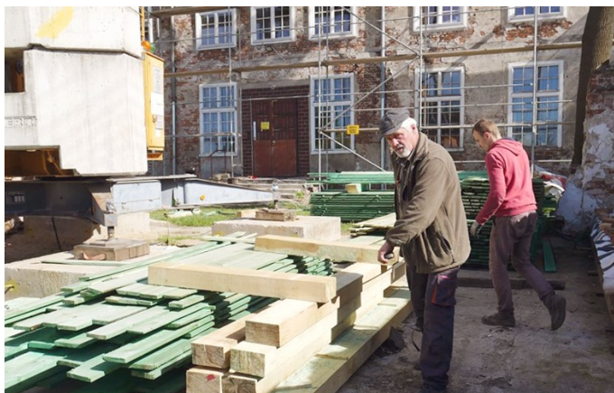
Brat Michał Cieślarski przez pierwsze dwa tygodnie remontu przeprowadził prace ciesielskie przy konstrukcji dachu
