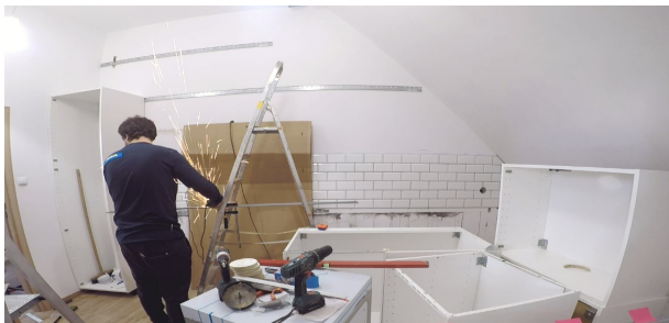
Koniec sierpnia był czasem intensywnych prac przy montażu kuchni na piętrze kaplicy
