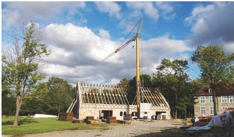
Profesjonalny dźwig budowlany użyty przez firmę Portal
