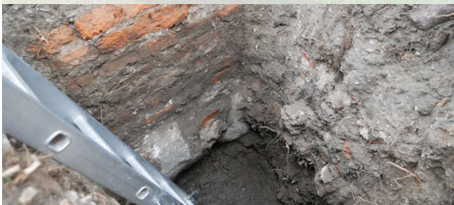
Konstruktor określi czy w przyszłości nowy budynek będzie mógł opierać się na starym fundamencie
