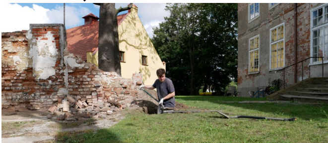
Odkopywanie fundamentów stajni, która uległa zawaleniu w 2005 roku
